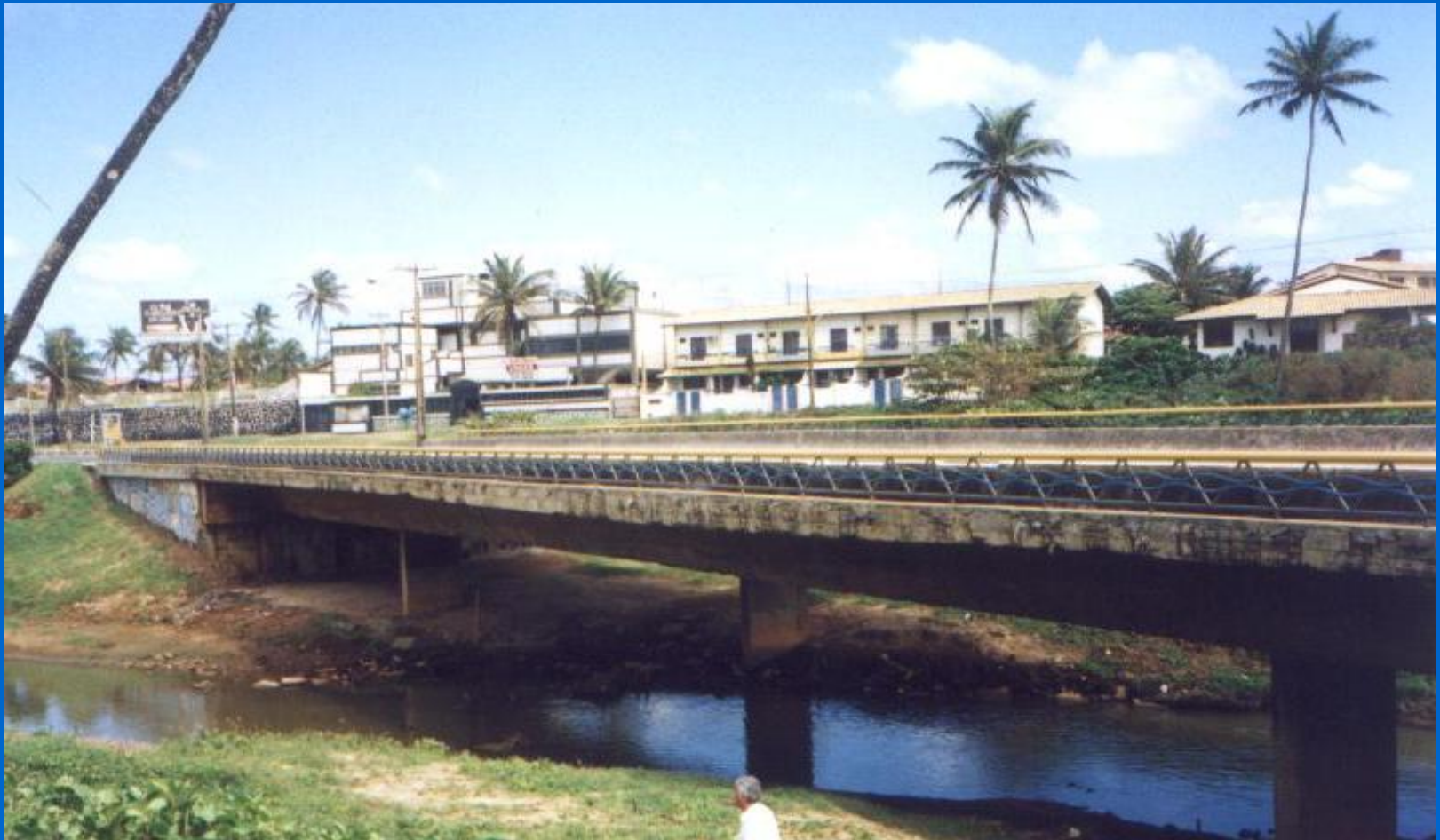
Ponte sobre o rio Jaguaribe, Salvador, BA, 1984
