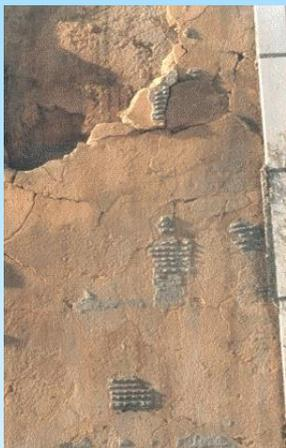
Fissuras mapeadas devido a possível retração da argamassa de base do revestimento cerâmico. Segundo a NBR 13749, Anexo A, as fissuras mapeadas podem ser decorrentes de excesso de finos, excesso de desempenhamento.
